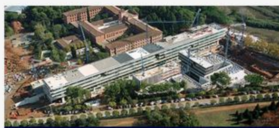
Nuevo campus Sant Cugat, 2009
